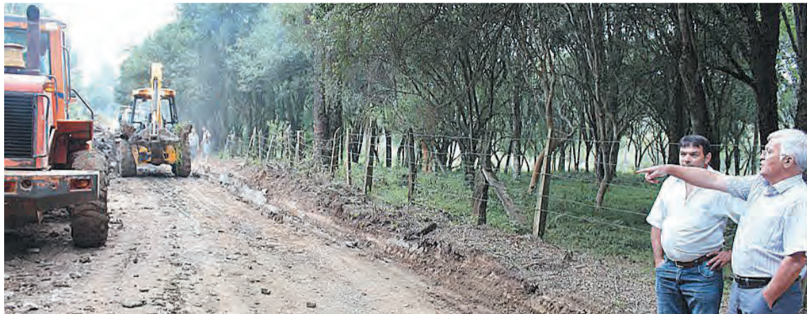
Obras devem terminar até o fim da próxima semana
