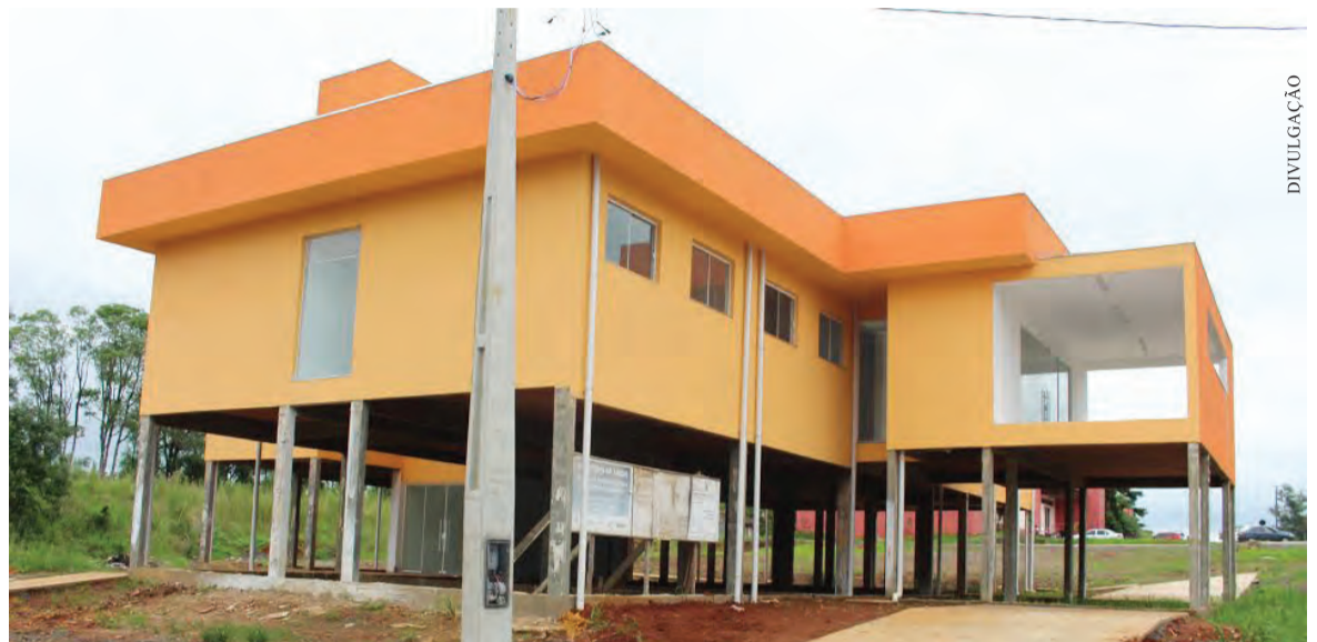
Único acesso à construção é uma escada que fica nos fundos
