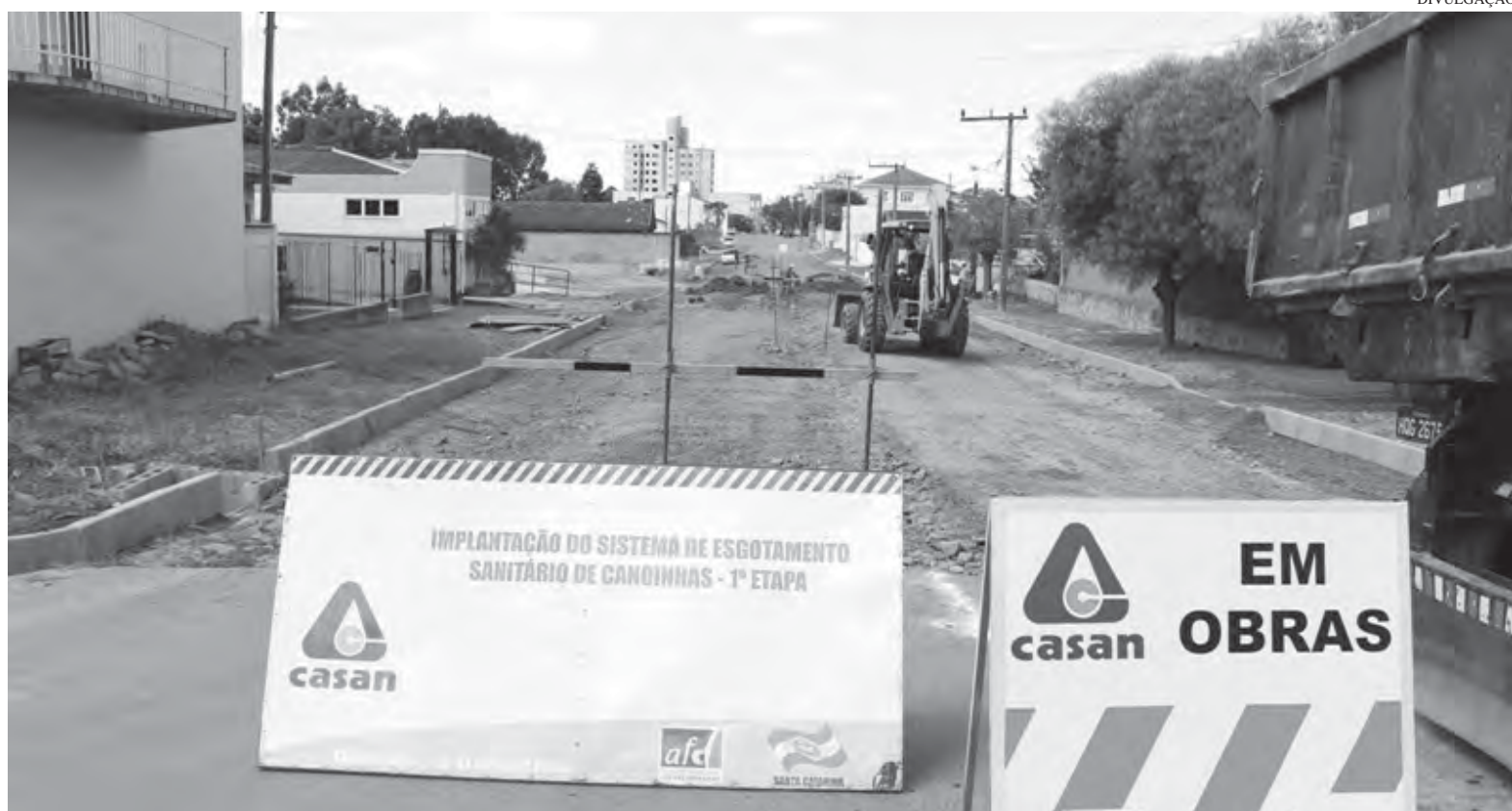
Início das obras de esgoto na rua Lourenço Mallucelli, onde foram feitas as primeiras ligações
