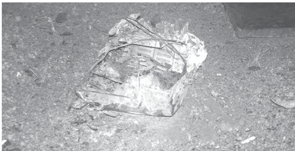
O princípio de incêndio foi controlado com extintores
