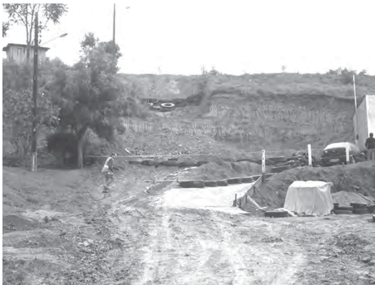
Local colocava em risco casas e uma igreja
