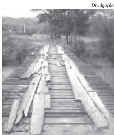
Ponte do rio Tamanduá
