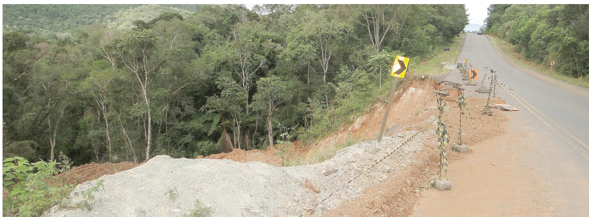
Em dia ensolarado, empresa licitada para fazer a obra na SC-280, não estava trabalhando
