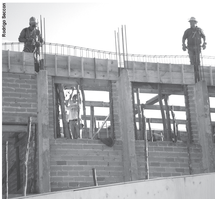
OBRAS começaram em maio e previsão de conclusão é de dez meses
