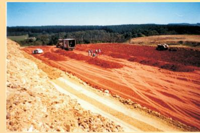
Sobre a geomembrana, é sobreposta uma nova camada de argila, sobre a qual o lixo é depositado e compactado
