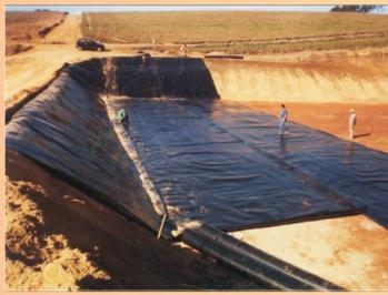
No aterro, sobre uma camada de argila, é instalada uma geomembrana, extremamente resistente
