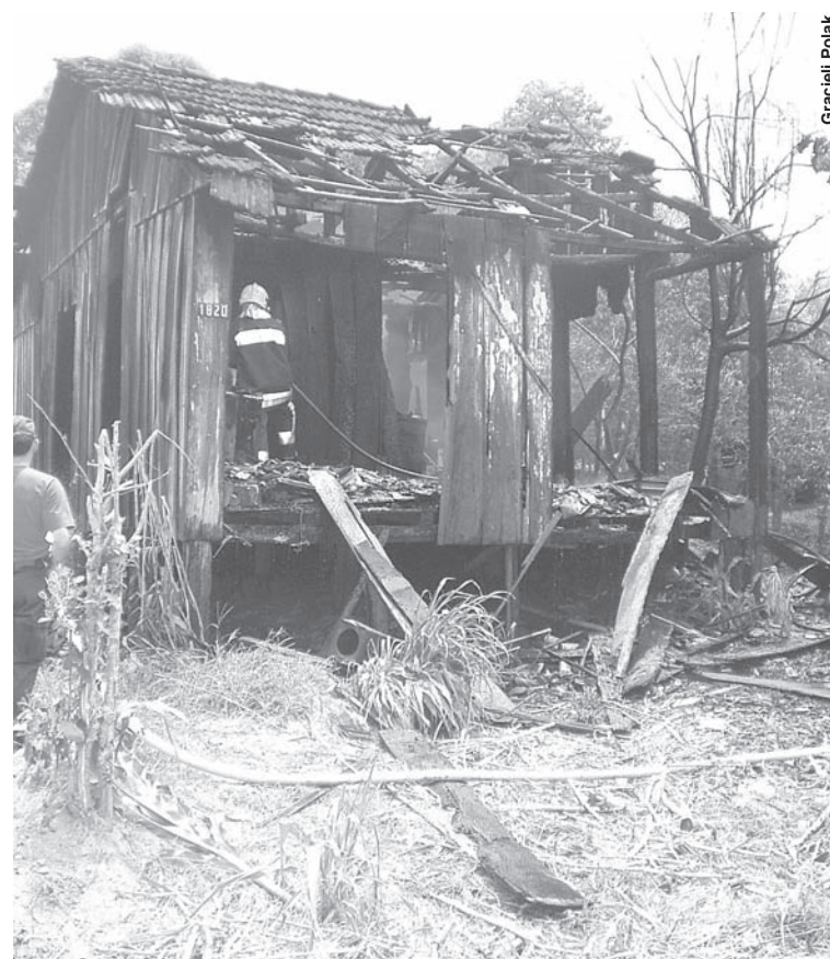
CASA de madeira tinha aproximadamente 35m 2 e foi rapidamente consumida
