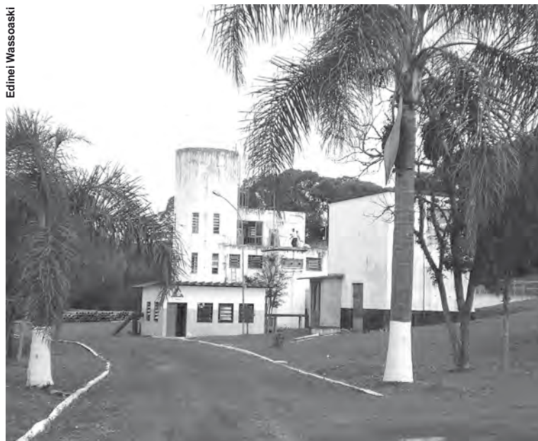
POLÊMICA: Estação de tratamento da Casan em Canoinhas
