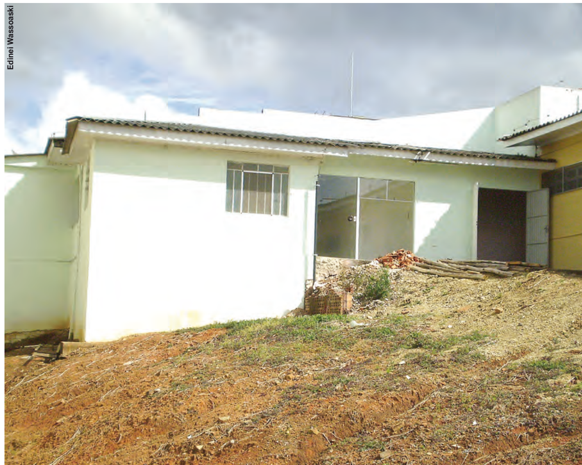
EM OBRAS: há mais de dois anos o Banco de Sangue do HSC começou a ser montado, mas segue inconcluso
