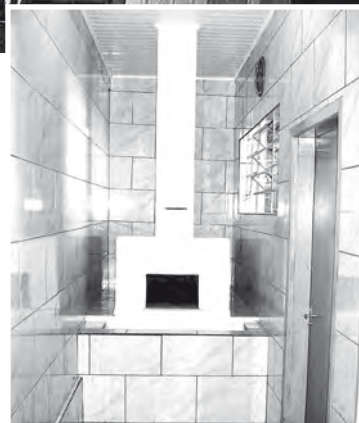
Forno à lenha da Sala de Panificação
