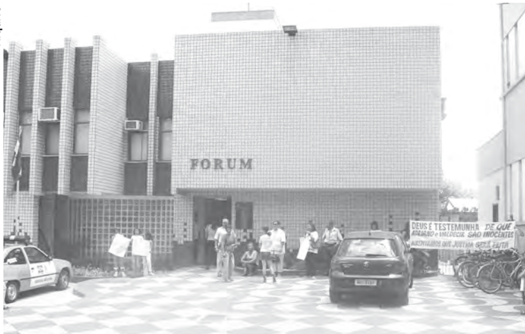
Atual estrutura do Fórum da Comarca seria insuficiente para 3. a Vara
