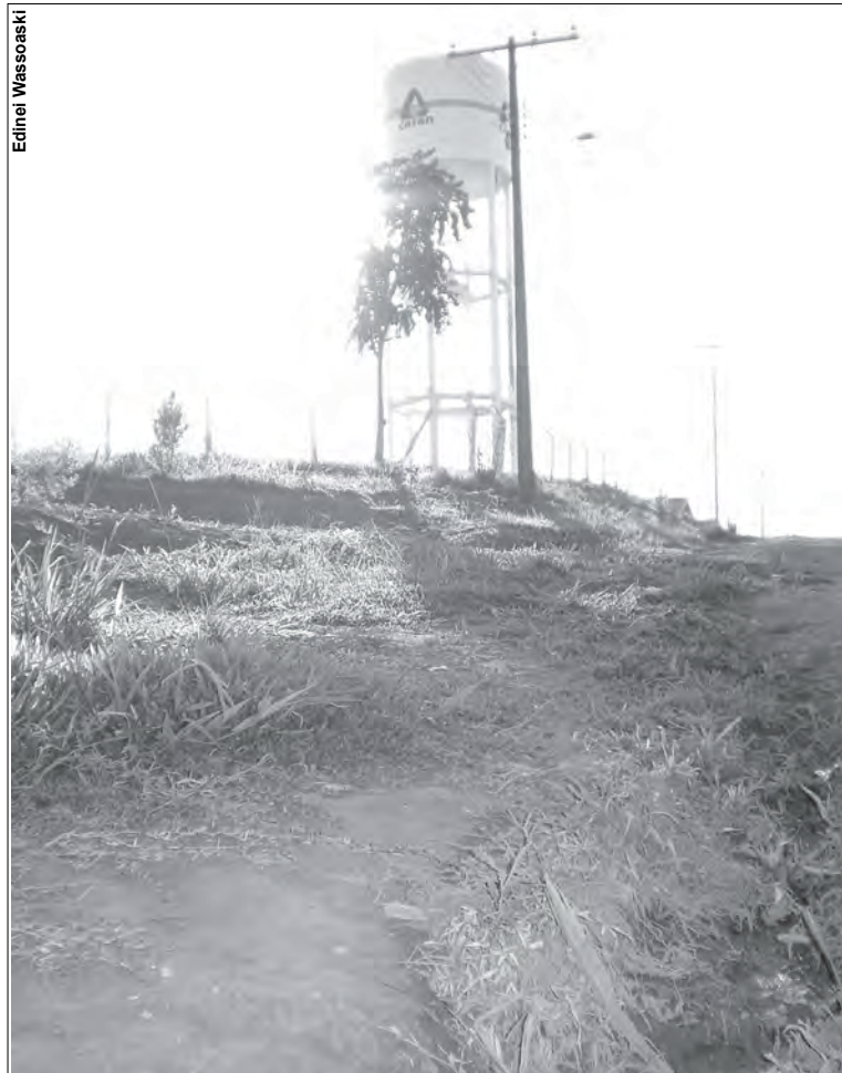
Vazamento do reservatório (ao fundo) formou um córrego incessante na rua
