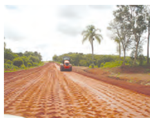
Etapas finais da terraplanagem no desvio da SC – 303
