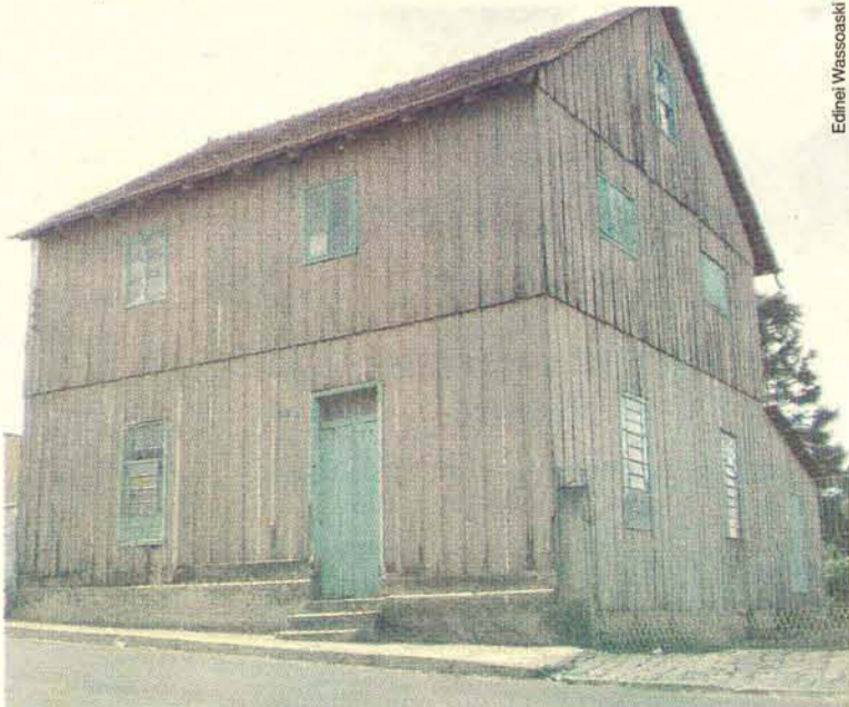
Barracão onde Evaldo descascava arroz, na rua Roberto Ehlke, resiste ao tempo
