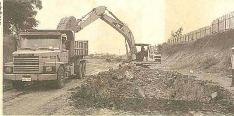
Máquinas trabalham no corte do terreno do desvio da SC-303
