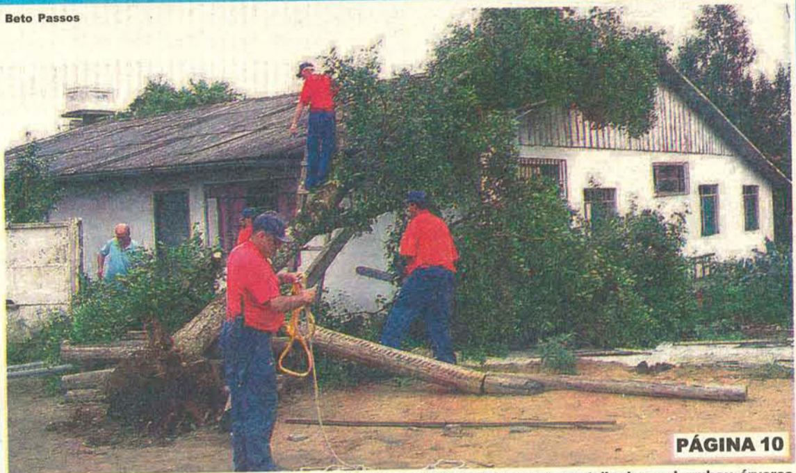
O forte vendaval que atingiu Canoinhas na noite de segunda-feira, 19, arrasou telhados e derrubou árvores e postes. A região mais atingida foi o bairro Campo d'Água Verde, onde 12 famílias ficaram sem teto
