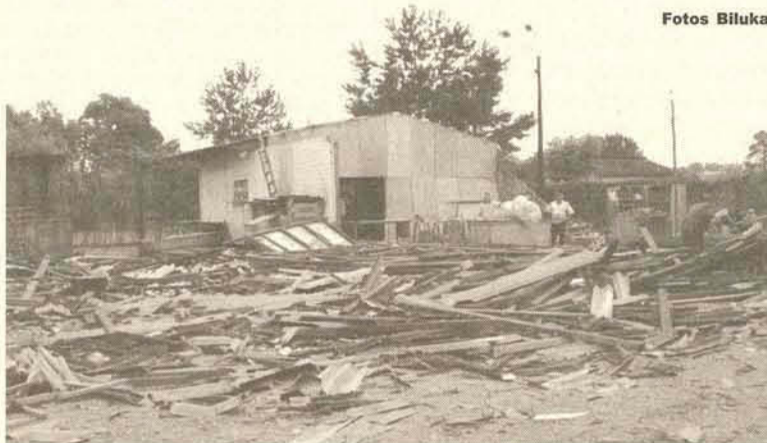
Casa no Campo d'Água Verde, foi destruída pela ação do vento
