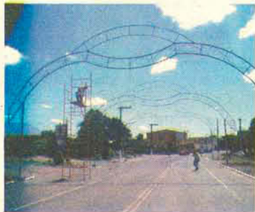
Operários trabalham na colocação dos arcos
