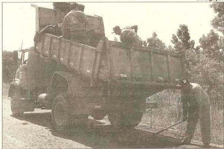
Tapa-buracos é paliativo, mas deve melhorar as condições de tráfego na rodovia
