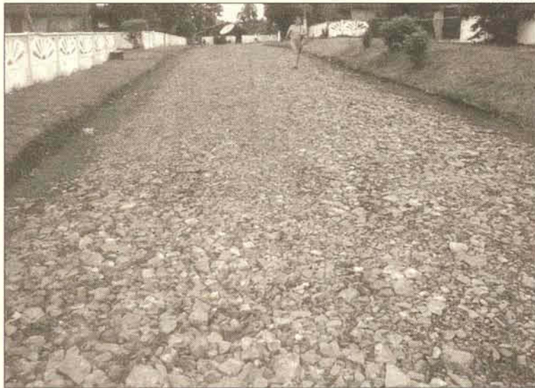
Entre as sete ruas arrumadas, duas receberam pedras britas
