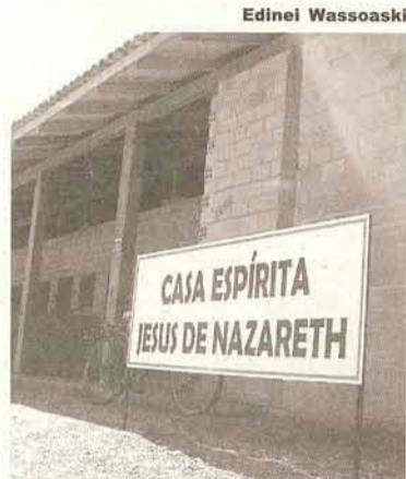
Casa ainda está em construção
