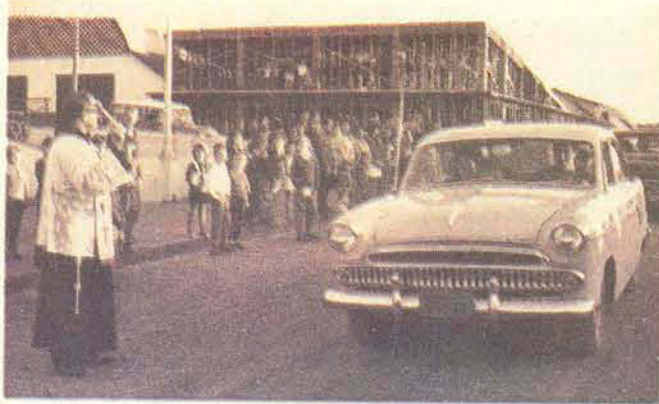
Ecilda e José desfilam com seu carro para receber a bênção do vigário. Ao fundo, o antigo cinema em construção
