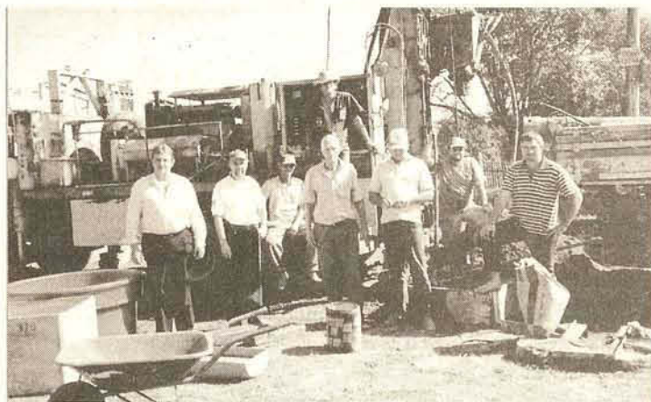
Trabalhadores posam em frente às obras de um dos poços
