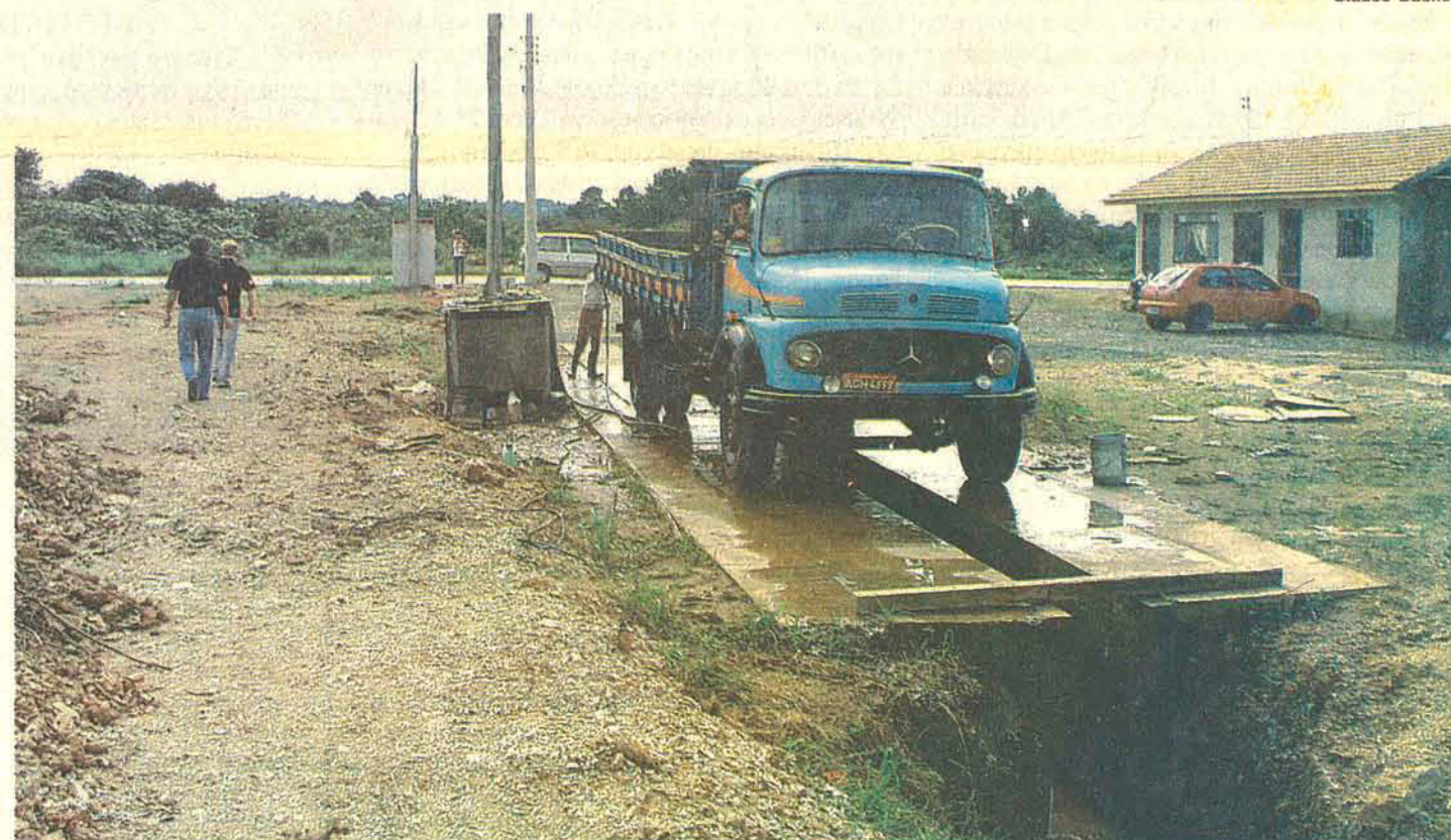
Posto de lavação de veículos está com documentação insuficiente para legalização
