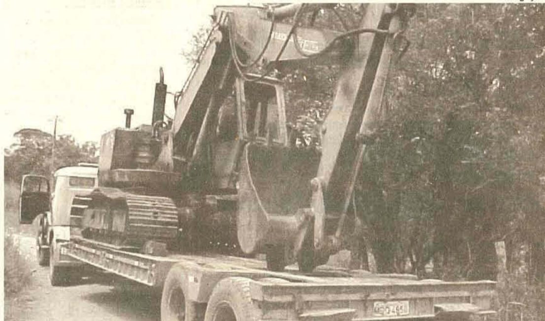
Retroescavadeira hidráulica irá auxiliar na limpeza do rio Papanduva
