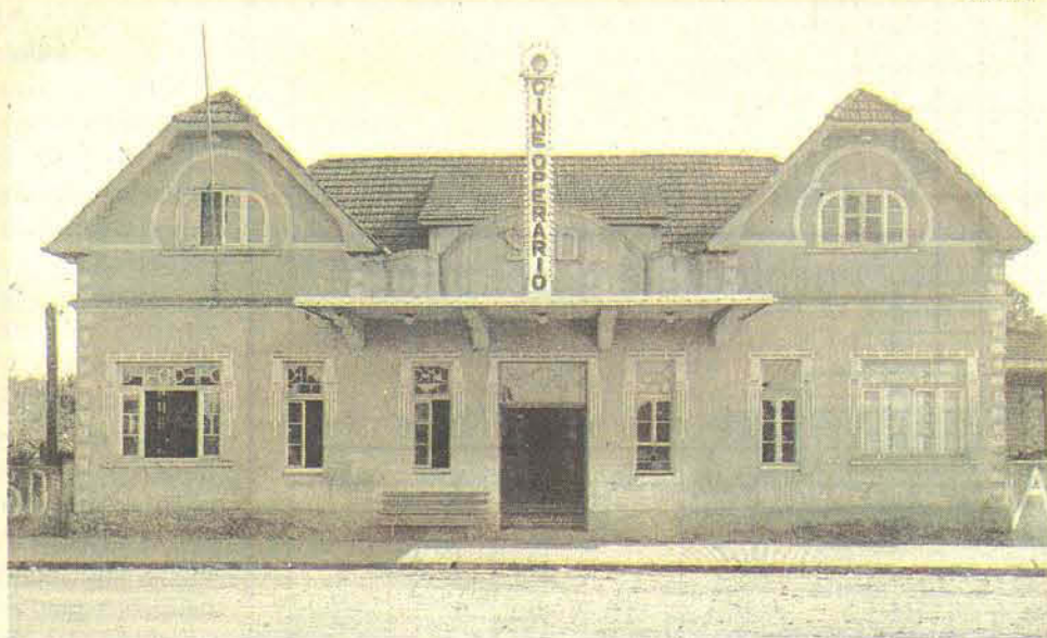
Cine Operário, na década de 50, instalado hoje onde funciona a SBO
