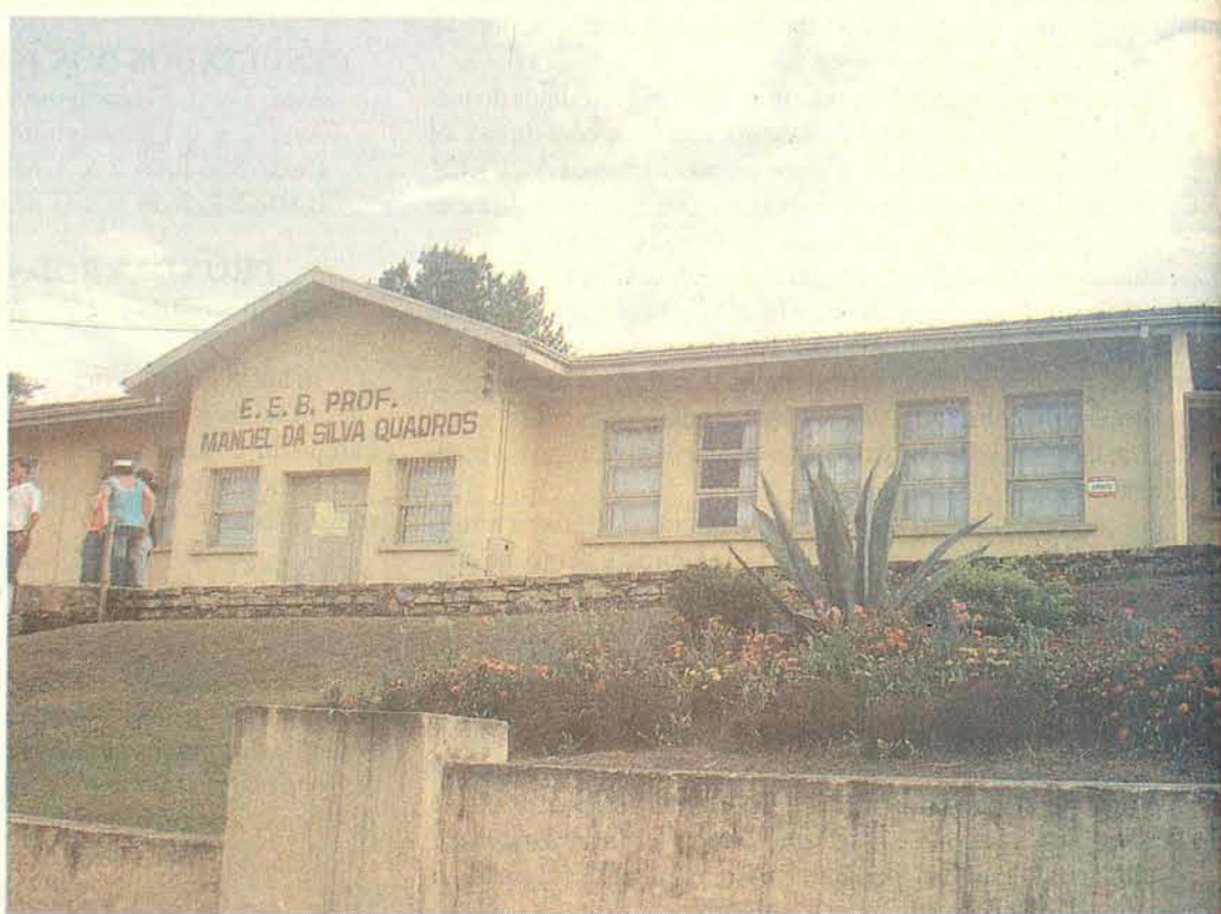
Fachada da E.E.B. Manoel da Silva Quadros
