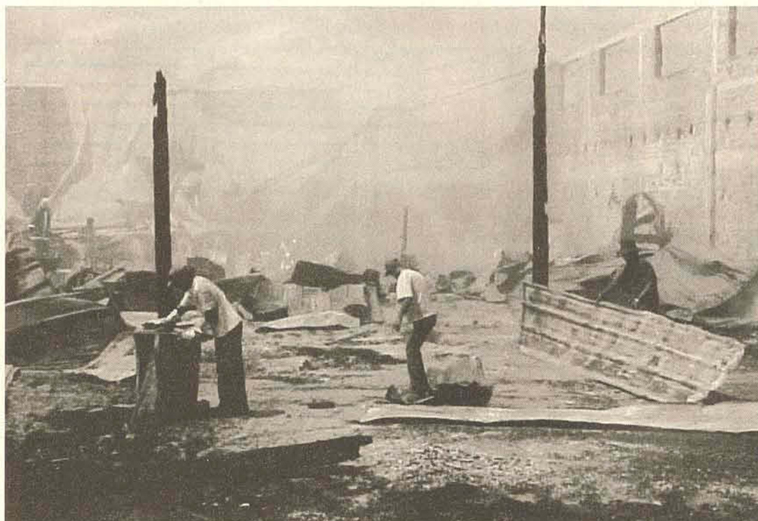
Funcionários desolados, recolhem os destroços do incêndio
