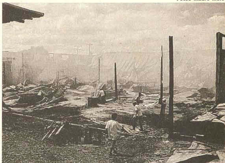
A destruição provocada pelo fogo foi total
