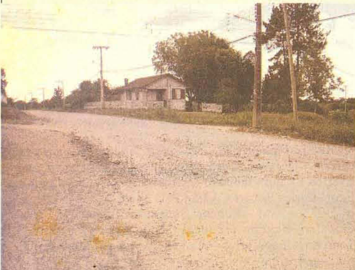
Início do trajeto já está pronto para receber a camada asfáltica
