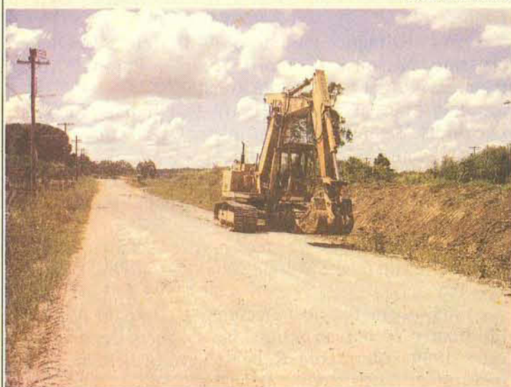
Máquinas estão terraplenando a pista
