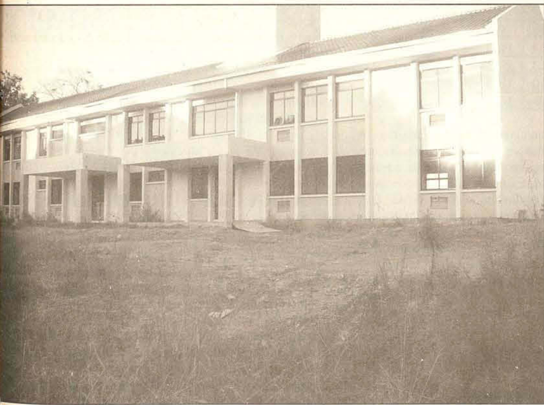
A Racitec teria abandonado a obra por não ter entrado em um acordo com o governo
