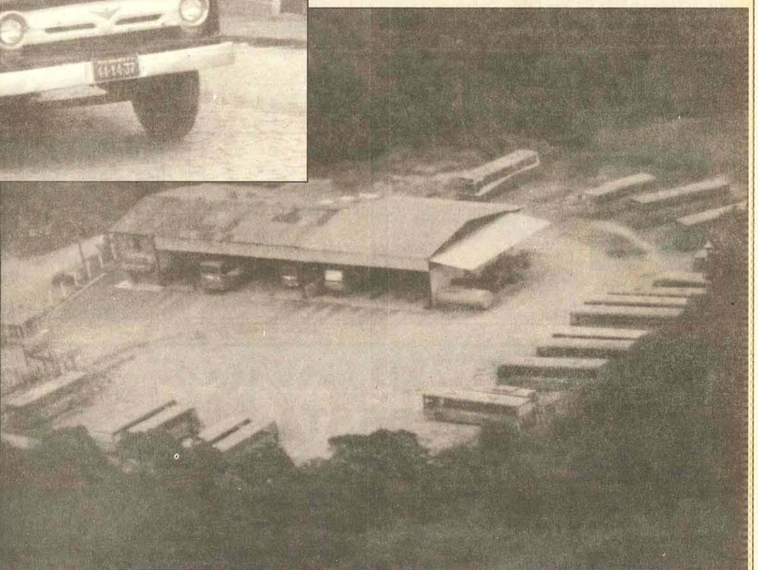
Vista aérea da sede da Empresa
