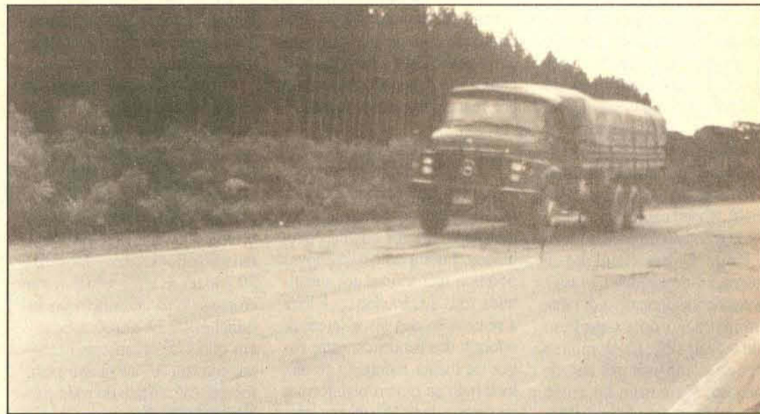
Condição precária da rodovia
