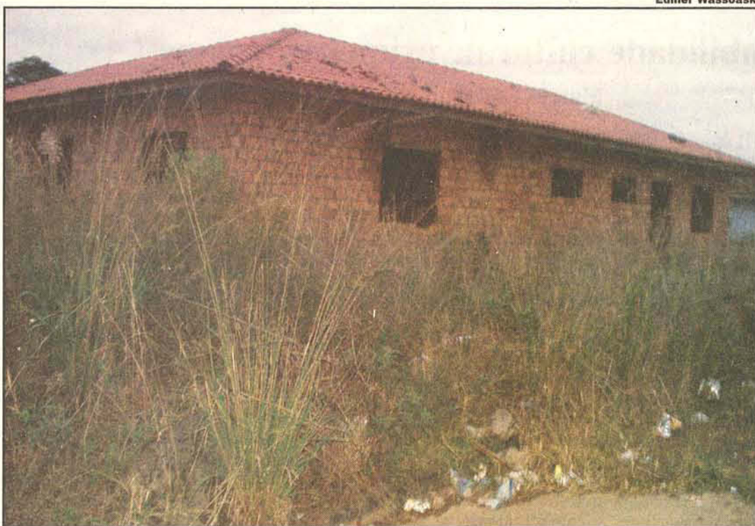
Obra da futura creche do loteamento Santa Cruz
