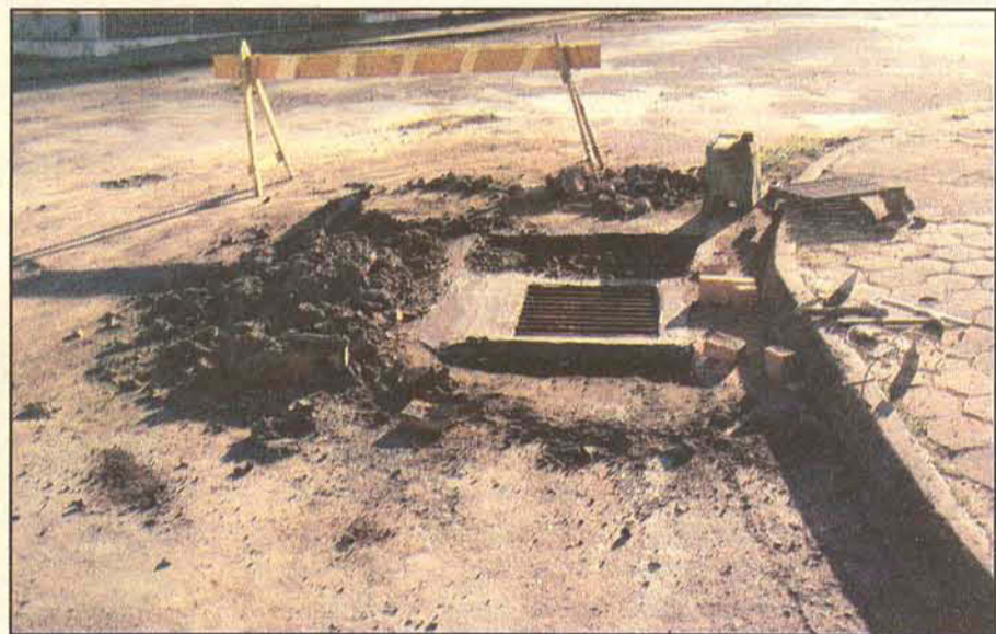
Tubulação trocada na Felipe Schmidt
