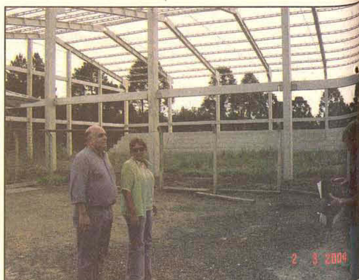
Gerente de projetos e obras da secretaria de estado da educação e inovação Maria Idalina Lemos Bohm, acompanhada dos engenheiros Roberto Domit de Oliveira (DeInfra Canoinhas), Rubens Eduardo Uhlmann (DeInfra Florianópolis) vistoriando as quadras.
