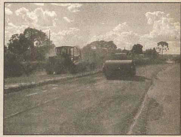
Máquinas e funcionários estão trabalhando e deve haver um cuidado grande nesse local, já que ali há um movimento intenso de veículos e pedestres.
