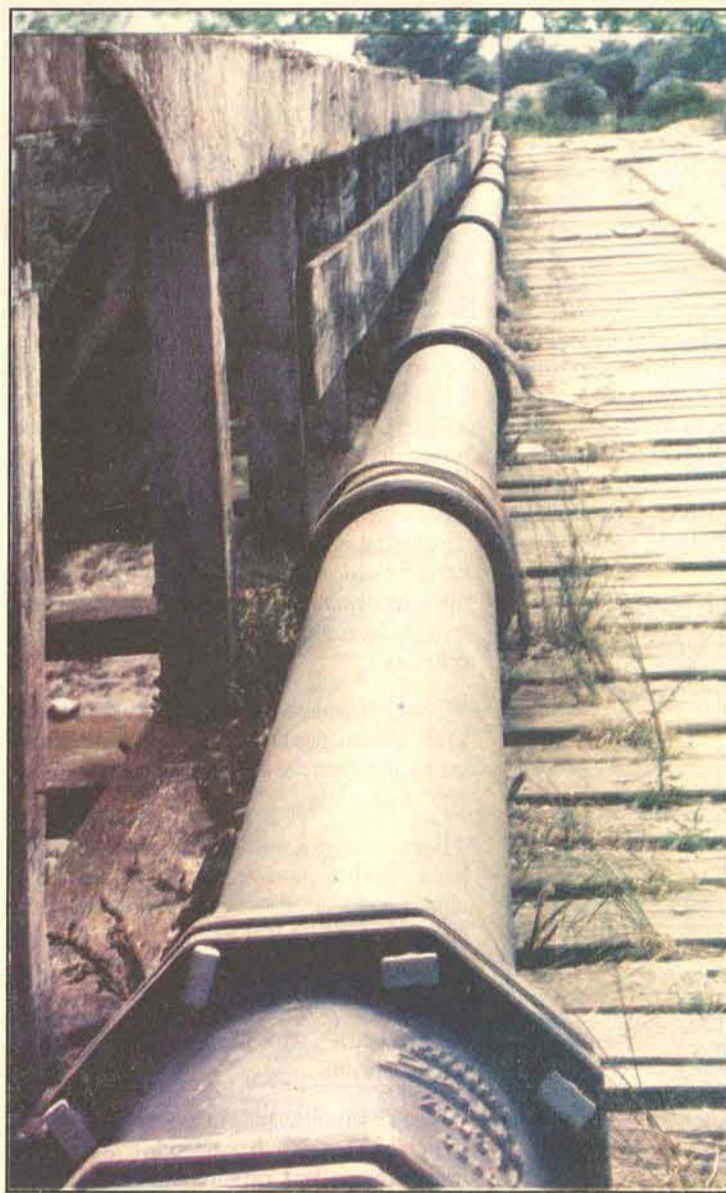
Tubulação da CASAN sustenta a ponte
