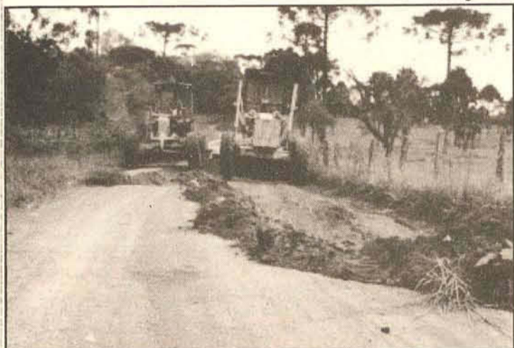
No início de janeiro foram realizados serviços em alguns trechos danificados
