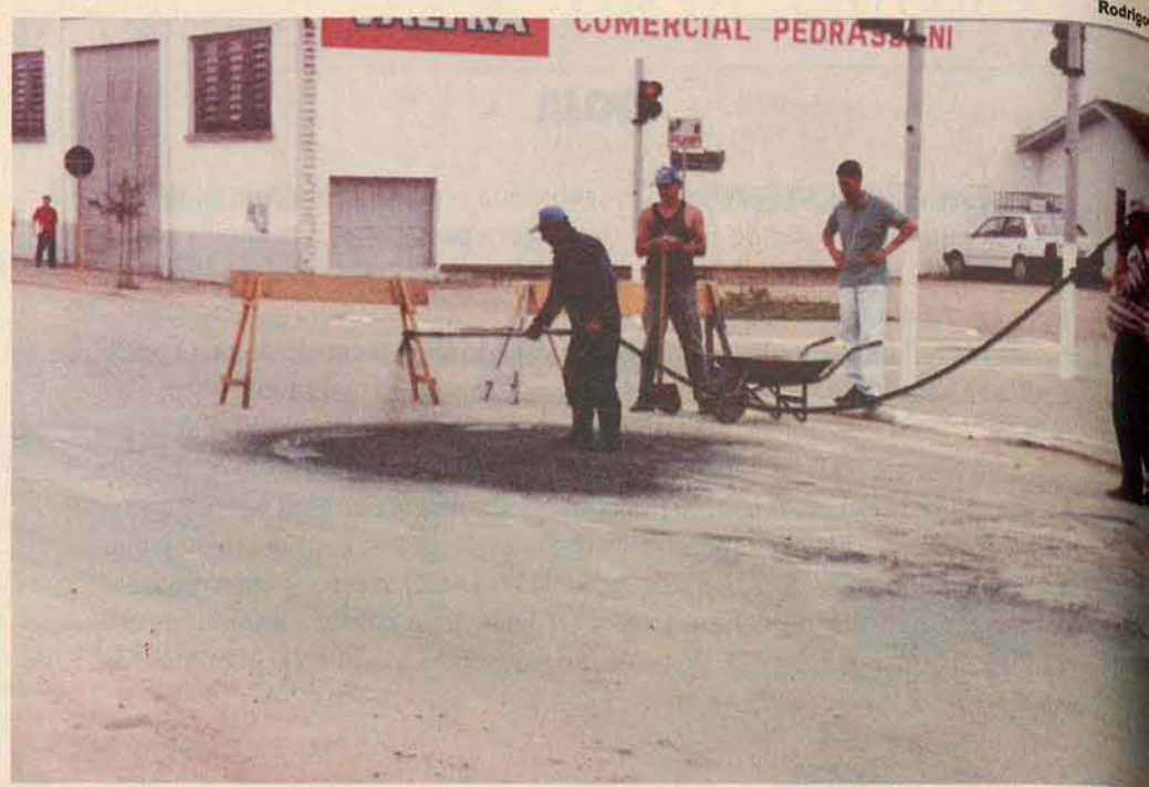
Funcionários trabalham na recuperação das ruas
