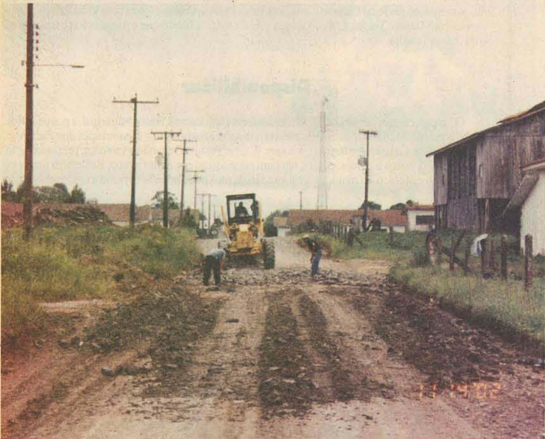
Máquinas trabalham na manutenção das estradas
