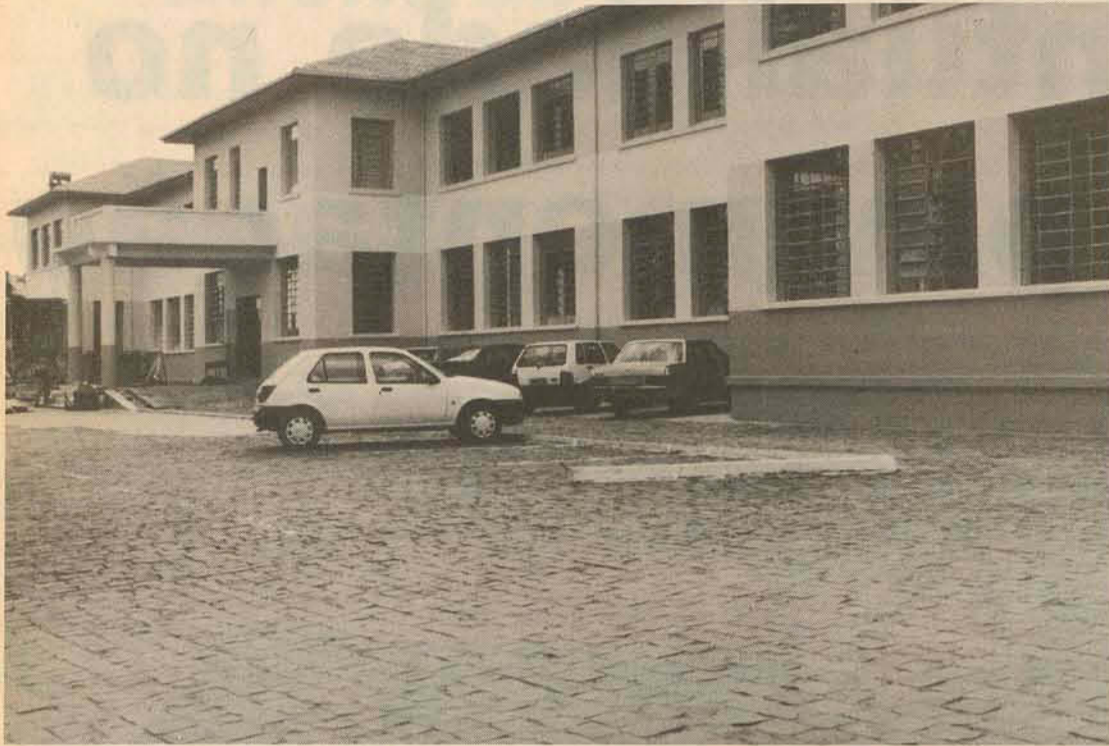
O prédio está sendo recuperado na sua totalidade. Investimentos de R$ 1.189.807,49
