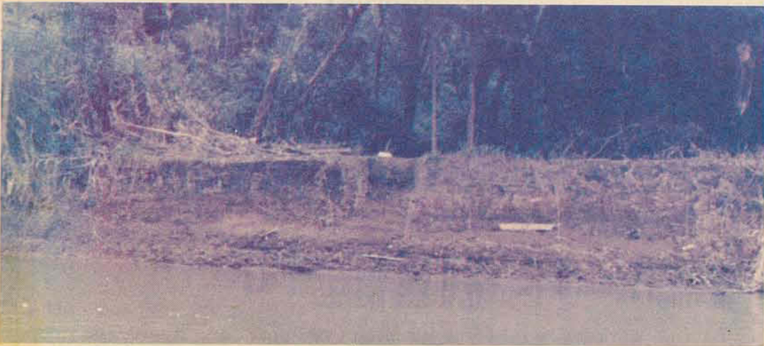
Devastação da cobertura vegetal e assoreamento com a destruição das barrancas
