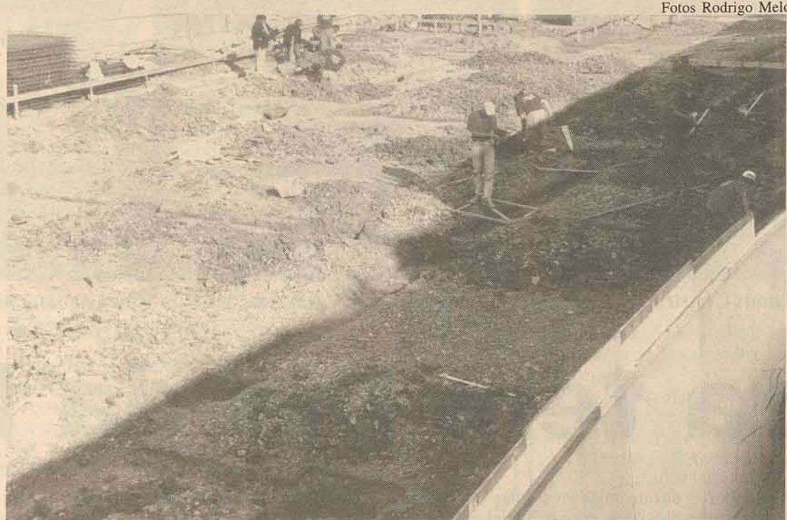
Funcionários começaram essa semana o início das obras na rua Três de Maio
