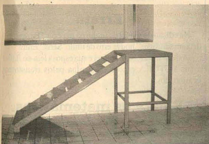
□ Obra com problemas e palco de apenas um metro meio de largura com escada inadequada
