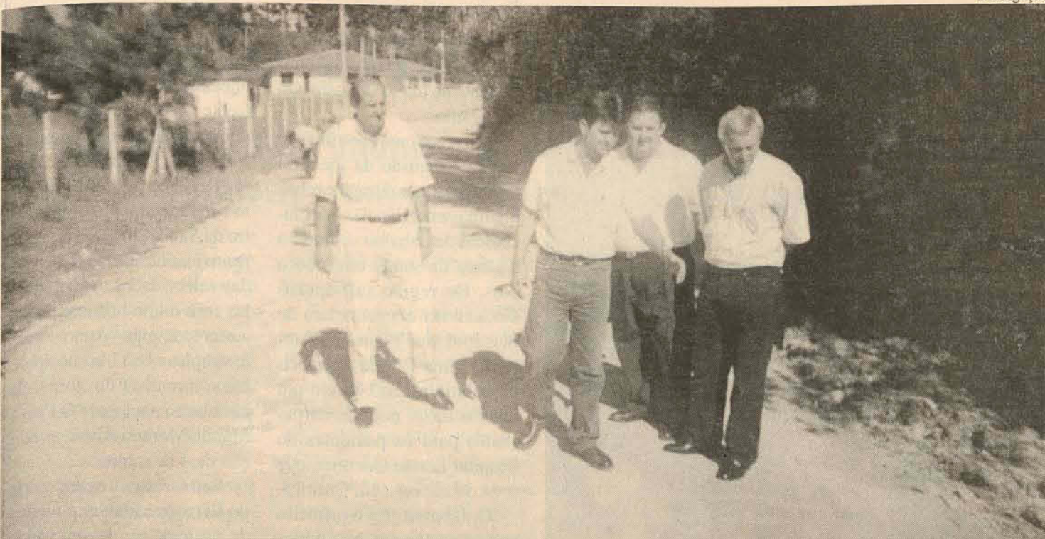
□ Prefeito Orlando Krautler e vereador Jaime Muehlbauer conferem junto com o engenheiro da Petrobrás e diretor de Obras da prefeitura de São José dos Pinhais o anti-pó
