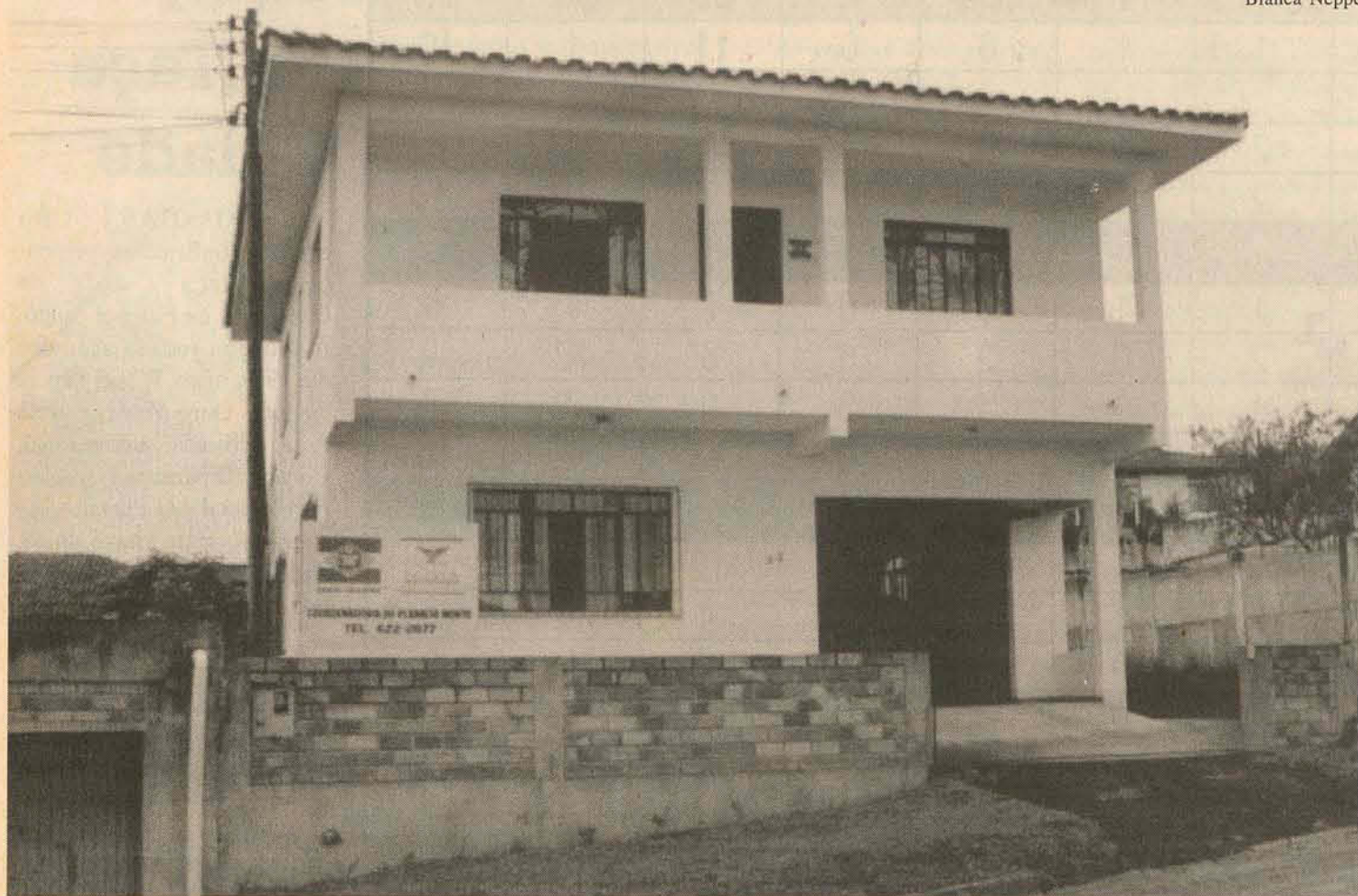
Sede da Fatma em Canoinhas: maior infra-estrutura para atender 18 municípios
