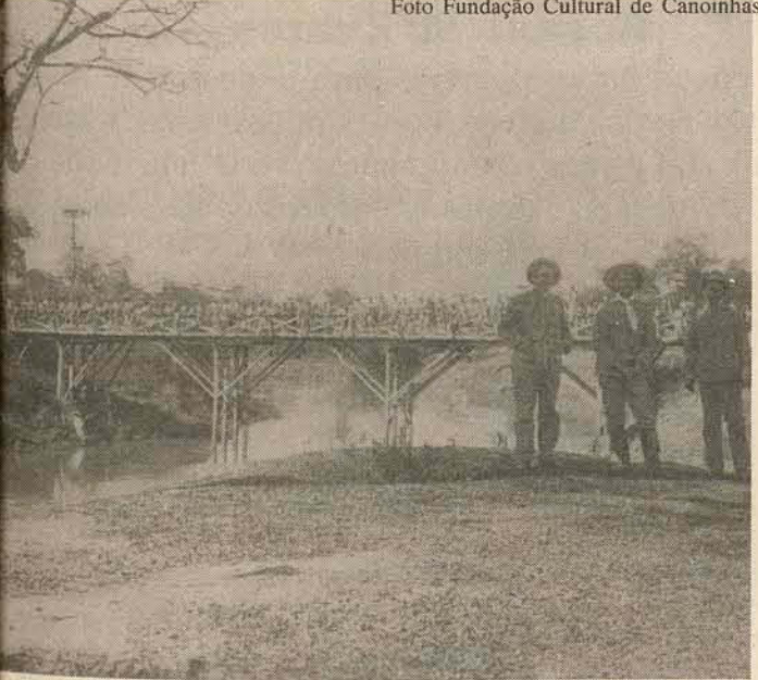
Inauguração da 1ª ponte do rio Canoinhas entre 1913 e 1914
