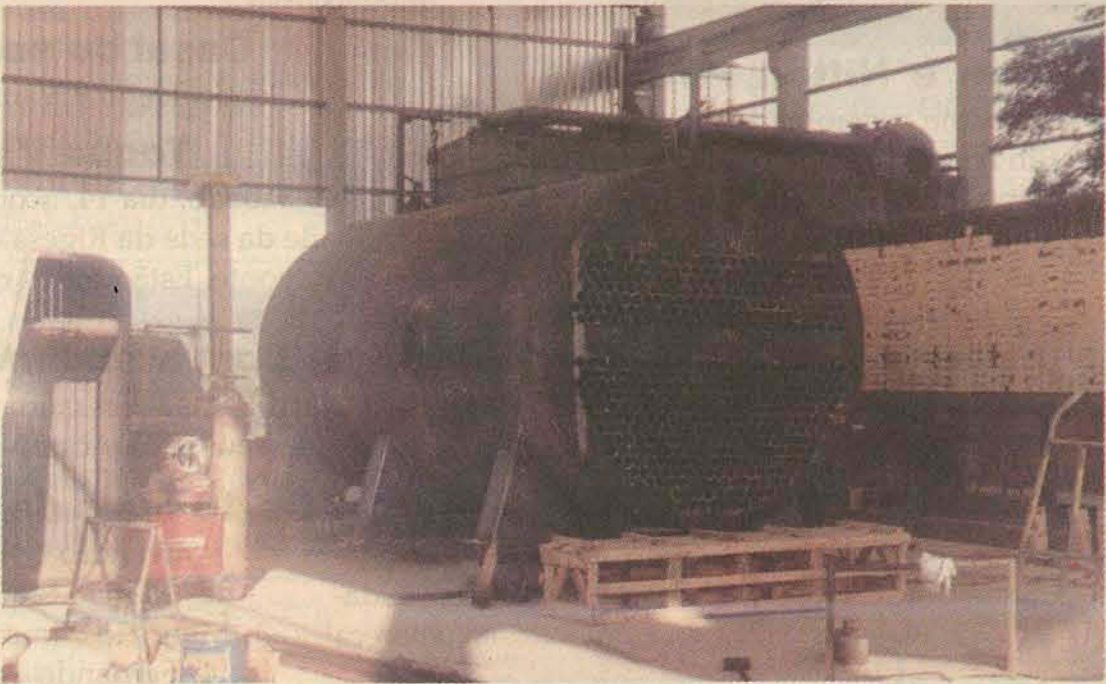
Caldeira está sendo montada em Rio do Sul
