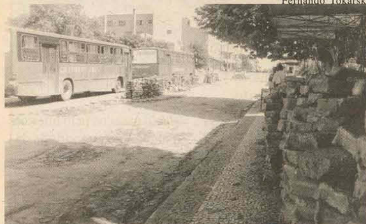
□ Lajotas são removidas para construção de galeria
