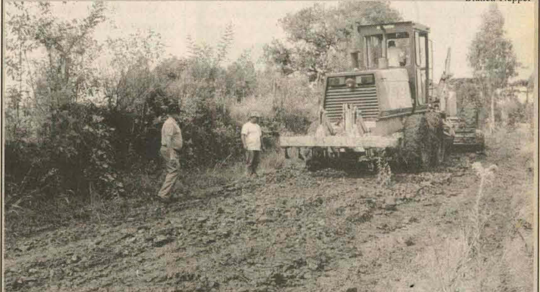
□ Prefeito Pedro Tyzka confere trabalho na estrada geral de Rio d'Areia de Cima, com patrolamento e cascalhamento
