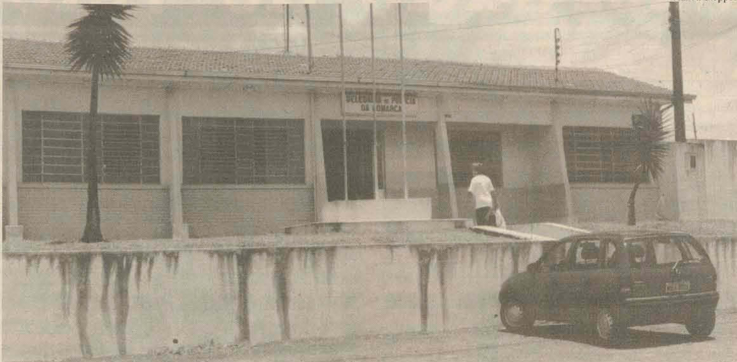
O prédio da cadeia, construído em 1963, não tem instalações adequadas para abrigar presos condenados
