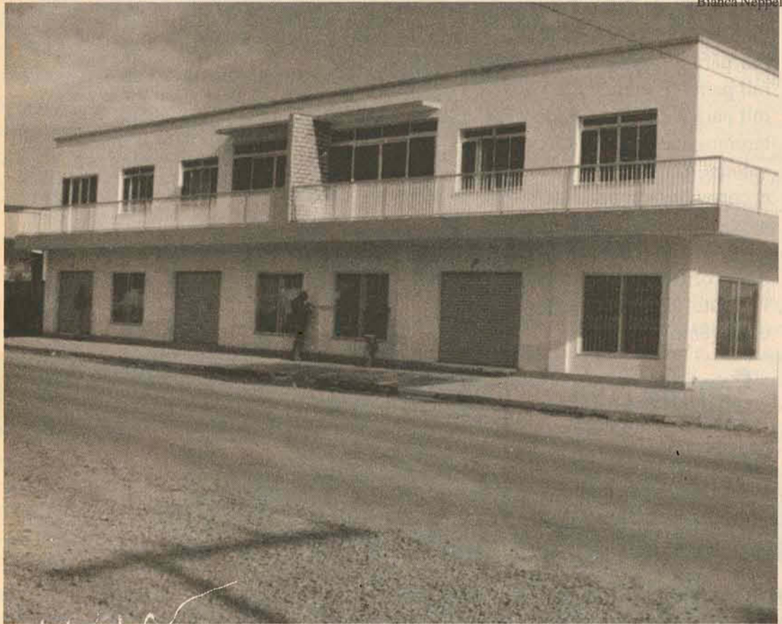
As obras no posto de saúde já custaram mais de R$ 10 mil: “dava para construir um imóvel para a prefeitura e não alugar”, dizem o vereadores
