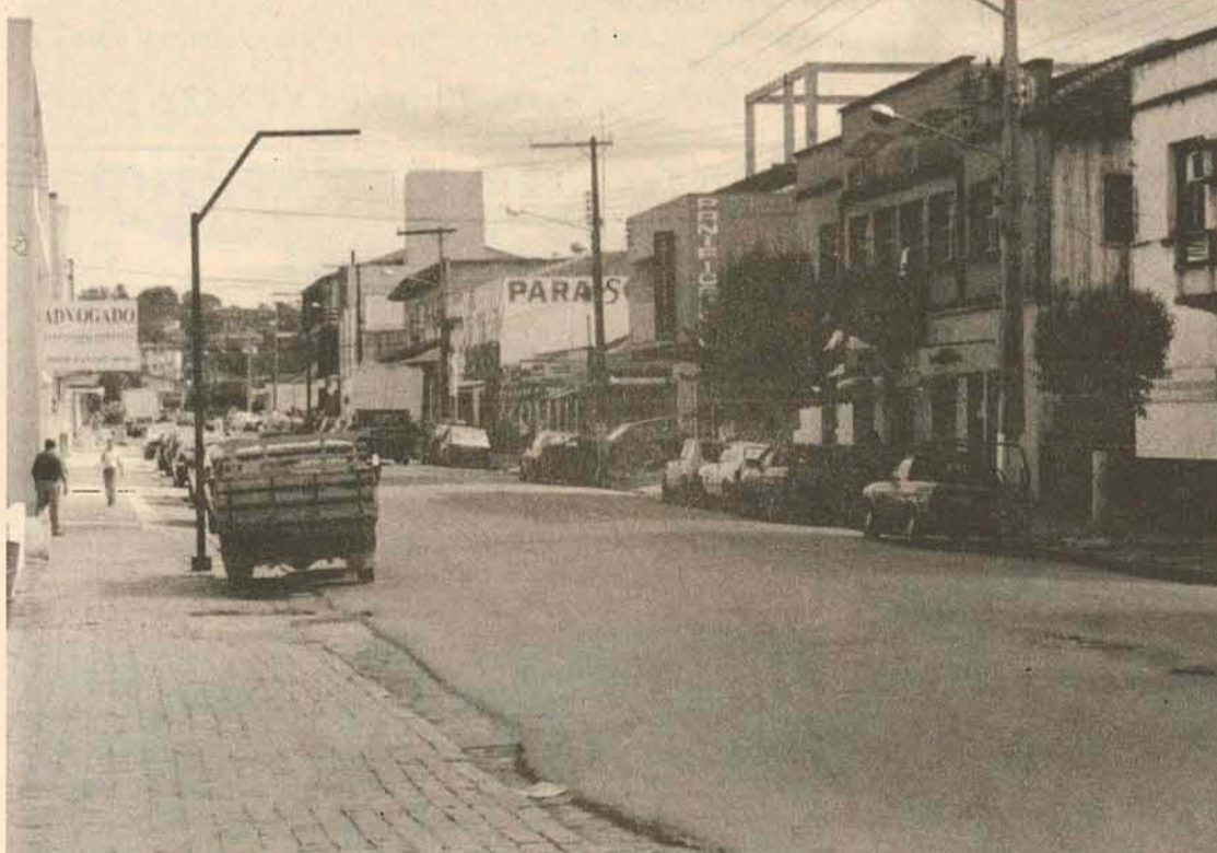
Apesar da negativa do Secretário de Obras, Irio Golanowski, as placas estão mesmo sendo retiradas
